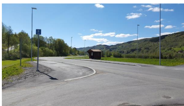
Bussholdeplass ved Bolmekrysset
