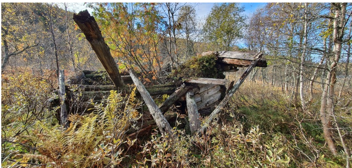
Figur 3. Sefrak Id 1567-0001-098. Forfalt høyløe fra andre halvdel av 1800-tallet. Foto: DBT/TRFK
